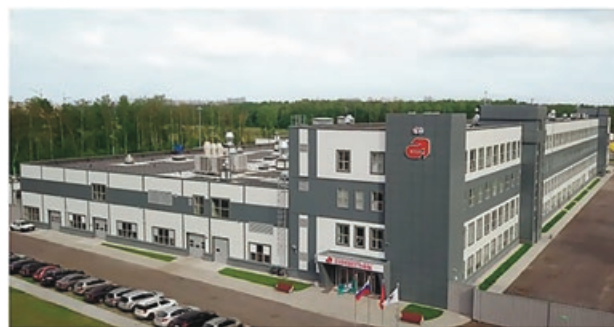
Рис. 9. Главное здание «АО ИЦ «Буревестник».
